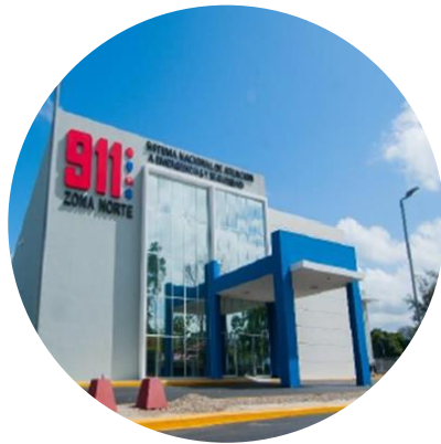
Sistema de Emergencias 9-1-1
